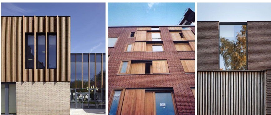
Kleur van het hout in de gevel sluit aan bij de tint van de baksteen om eenheid in de gevel te behouden.
